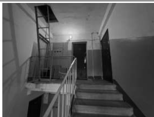
5.stāva kāpņu telpa
