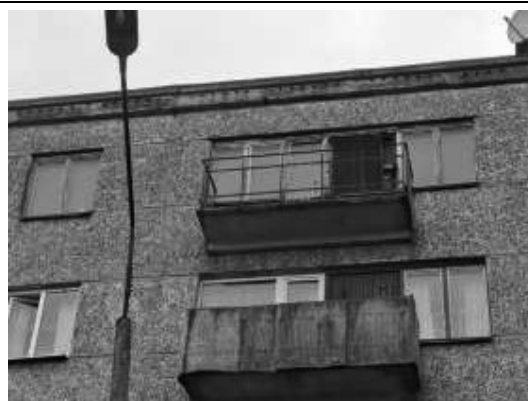
Dzīvokļa Nr.59 logi un balkons (5.stāvs)
